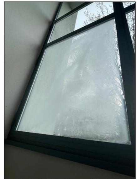
Abbildung 15: Fotos schadhafter und teilweise blinder Fenster und Dachfenster
